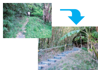
写真－5 市の補助金により、地域住民が整備した避難路
