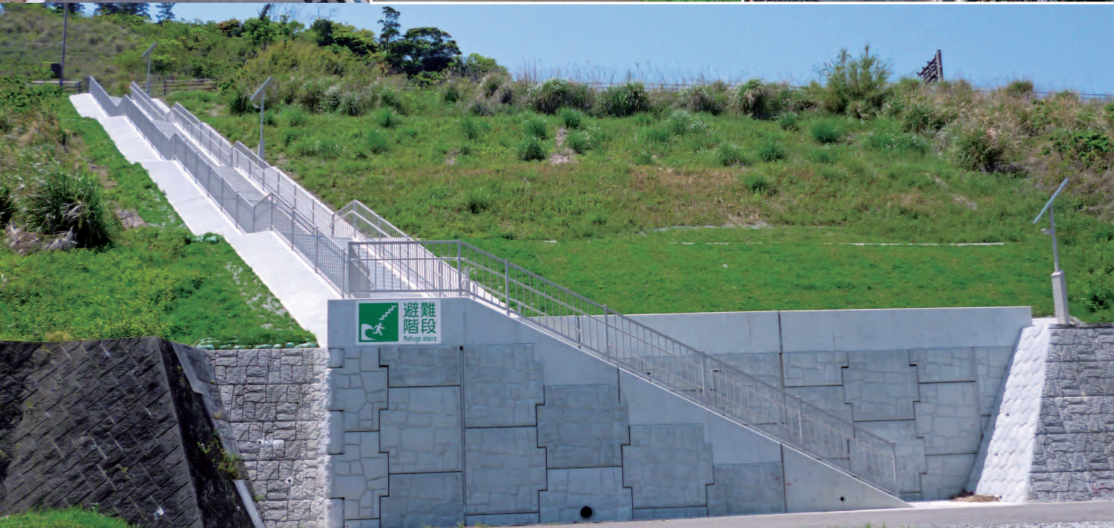
直轄国道220号の避難階段（宮崎市・青島地区）
