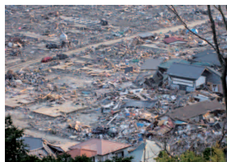
写真-1 2011年4月 被災地南三陸町の様子
