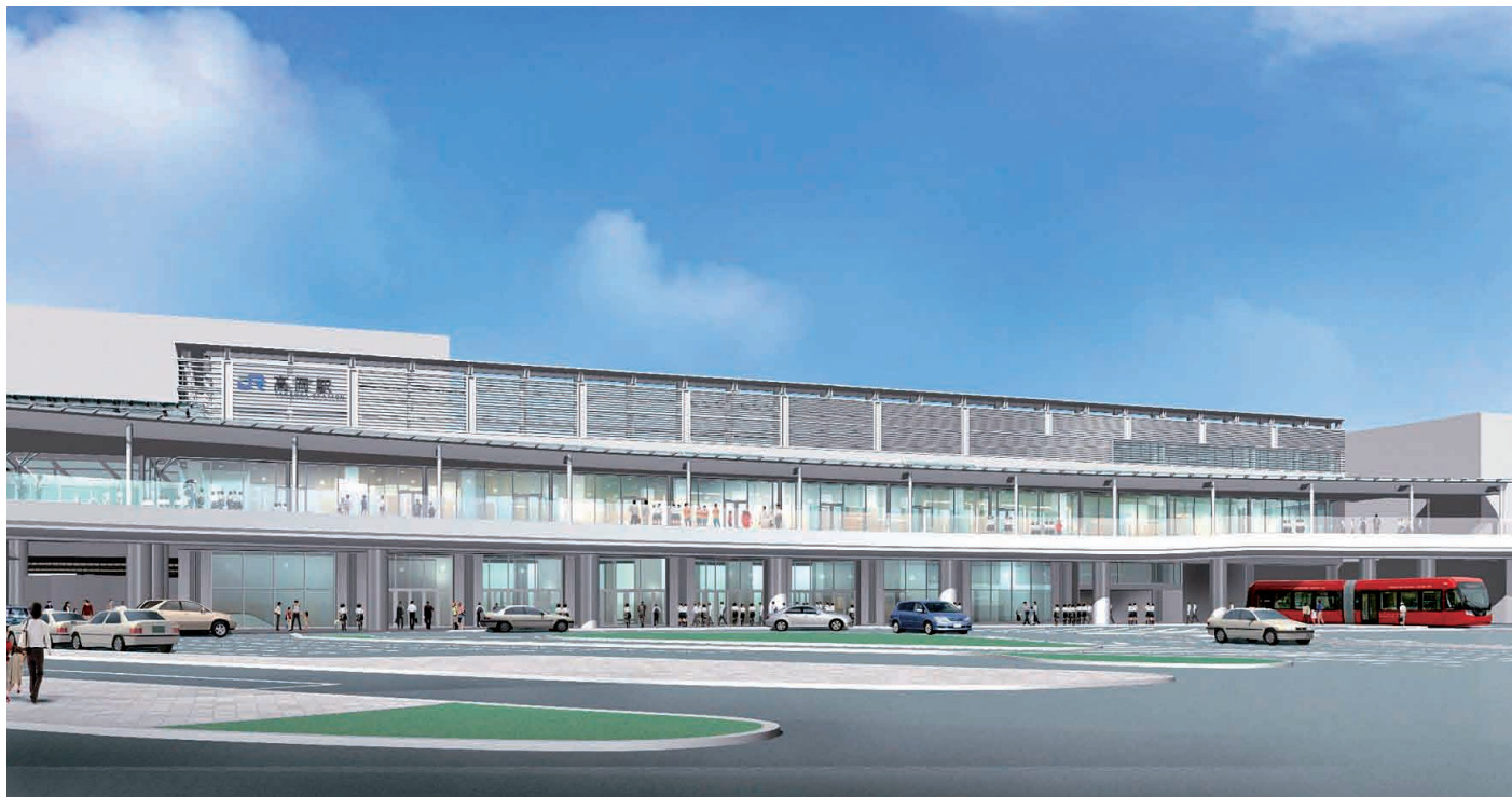
図-3 ステーションビル外観
