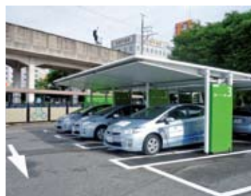
写真－1 PHVと充電施設
