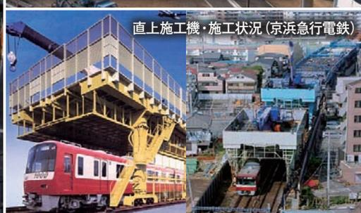
直上施工機・施工状況 (京浜急行電鉄)
