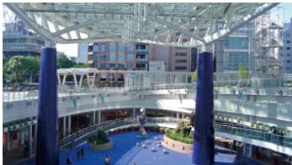
写真-1 名古屋オアシス21 立体的な結節点
