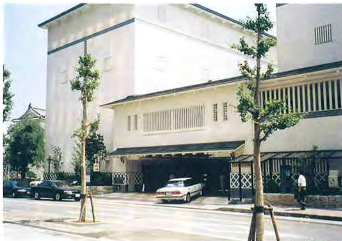
◀「なまこ壁」を活用したデザインの静岡 県庁青葉駐車場 (静岡市)
