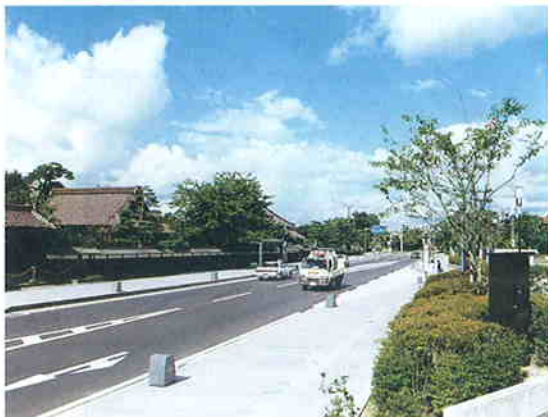
▲都市計画道路羽黒橋加茂線 街路改築事業（山形県）
