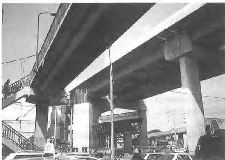
写真一 3 整備が進む第二高速道路の未供用区間
