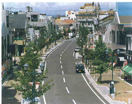
▲沿道区画整理型街路事業本町通線 （鹿児島県加世田市）
