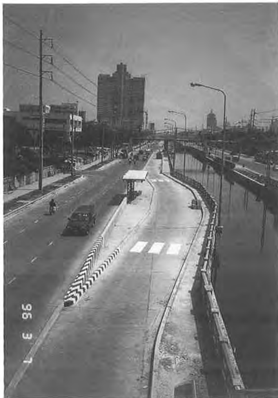
写真一４ バスの有効活用の切り 札として整備が進む Guided Bus System。
