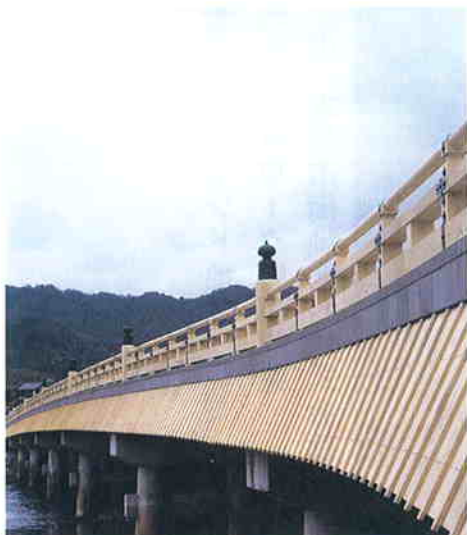
▲宇治橋橋梁整備事業（京都府）
