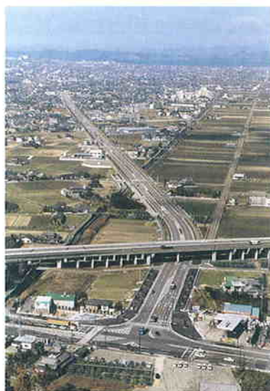
▲都市計画道路八代臨港線（熊本県、八代市）
