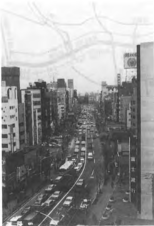
写真一 事業中（昭和56年） （四谷三丁目から新宿駅方面を望む）
