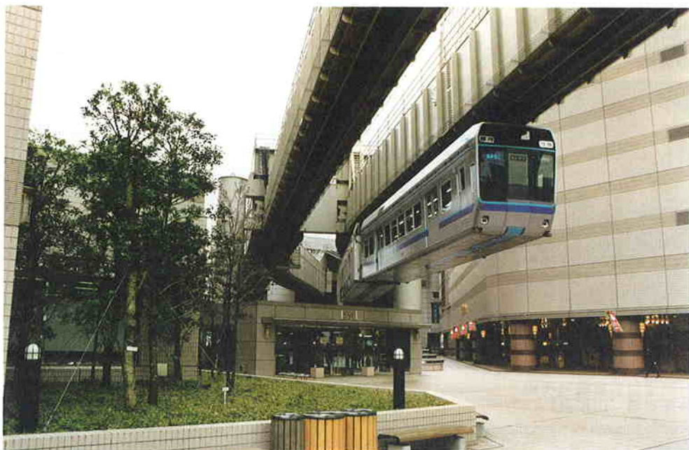
▲千葉都市モノレール建設事業（千葉県）
