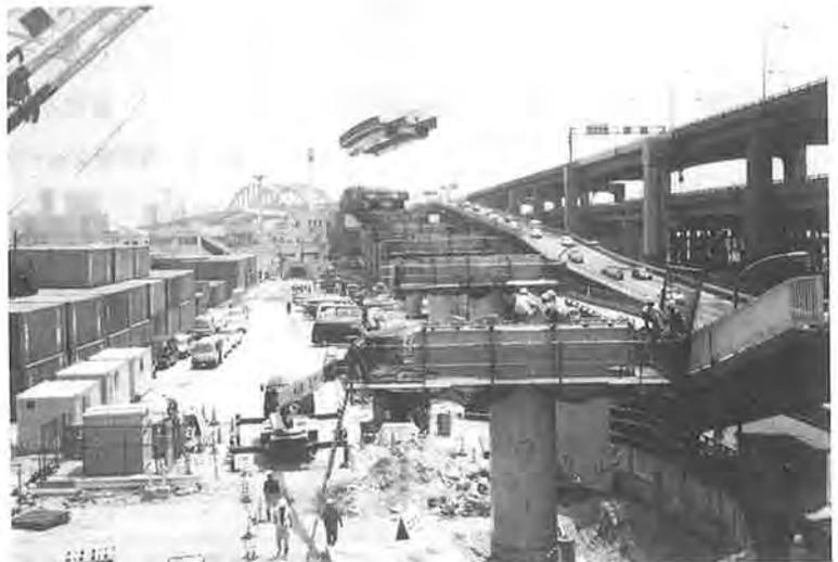
写真一6 新港第4突堤部橋桁架設
