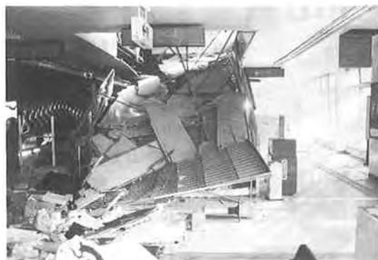
写真1-3 住吉駅コンコースの破損
