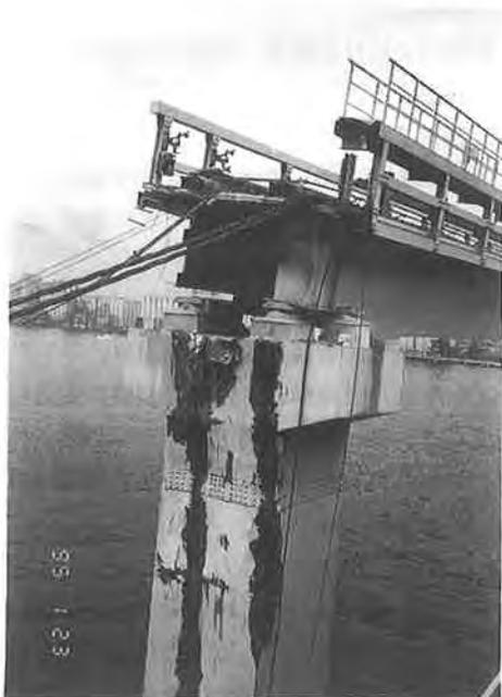
写真一五 桁の落下による鋼製橋脚の損傷
