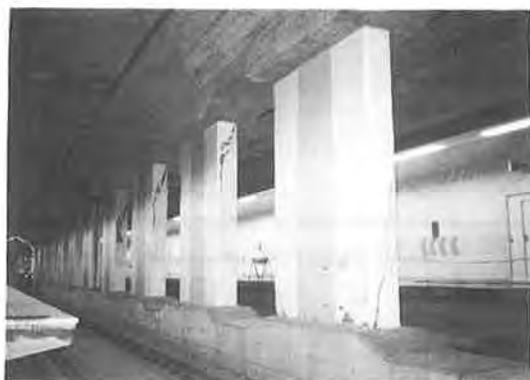
写真一 西代駅部中間柱の損傷
