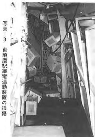
写真一 東須磨駅継電連動装置の損傷
