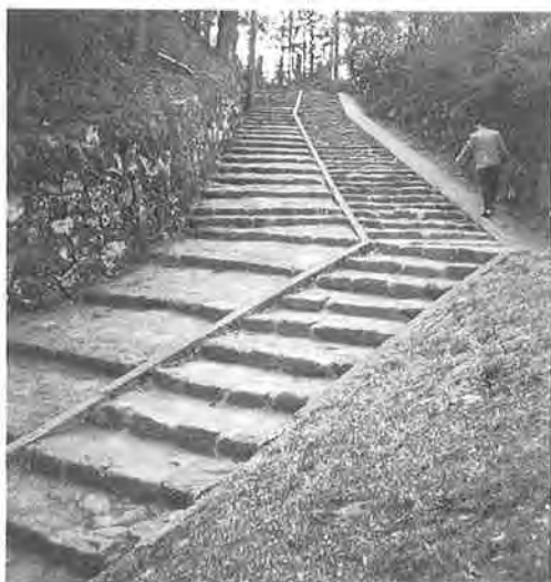
写真一 4 施工前
