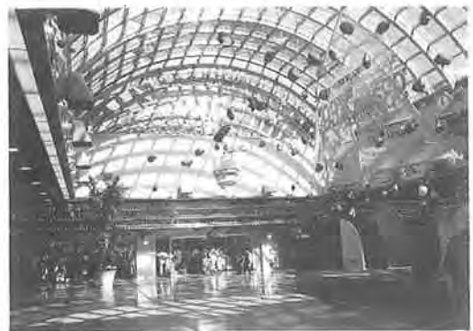
写真一 2 駅前広場地下広場部（可動シェル）
