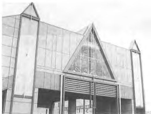
写真一七 通路西口正面
