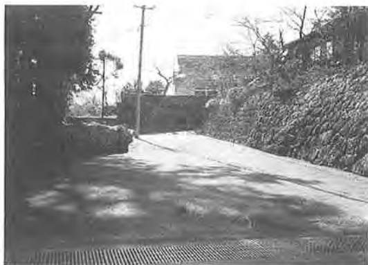
写真一 6 施工前
