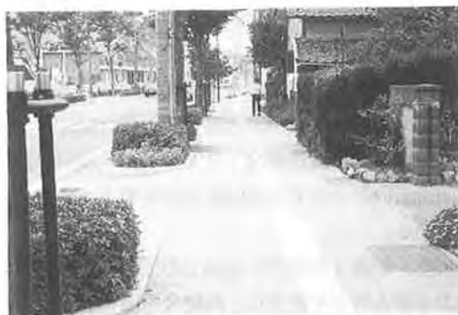
写真三 点字ブロックと歩道の切り下げ
