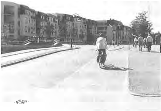
写真二 鉄道の下を通る道路 （右から歩道、自転車道、車道）
