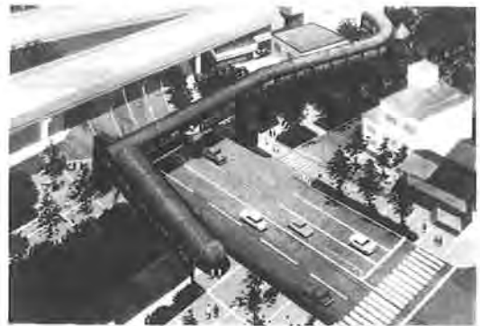
図-8 全天候型のペDESTリアンデッキ：図の右上が大物駅で左下が県立病院。図手前側にエスカレーター、道路両端にエレベーター2箇所を設置。
