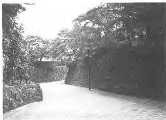
写真一 7 施工後
