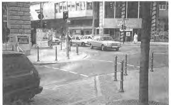
写真一 1 停車帯は舗装素材を替えてあり、交差点部分は停車帯を削って歩道を張り出している。
