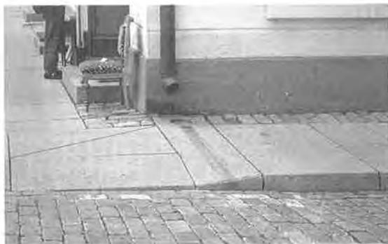
写真一七 厚みのある歩道の石材、雨道も石を削って作ってある。
