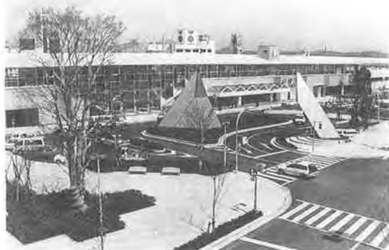
写真一 2 駅広と新幹線駅舎ファサード
