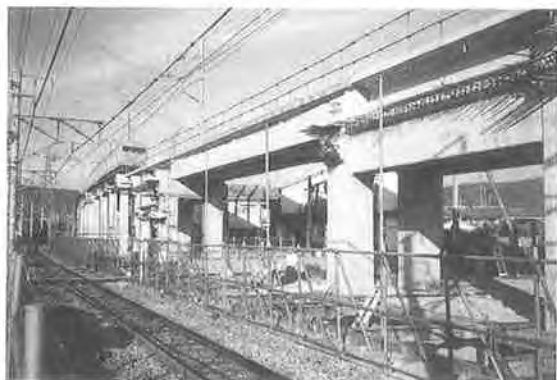
写真1 住道駅付近高架化工事
