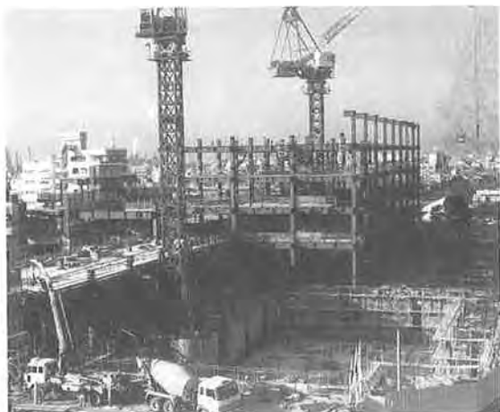
写真-2 東海道本線 住吉駅ビル新築工事
