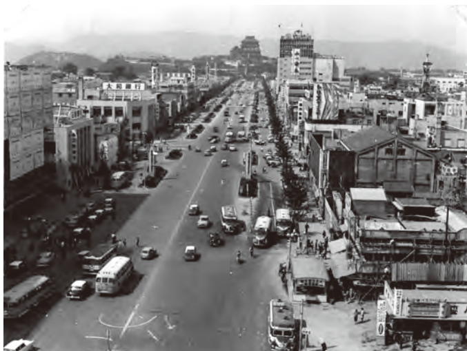
写真－1 大手前通りの完成（昭和30年）
