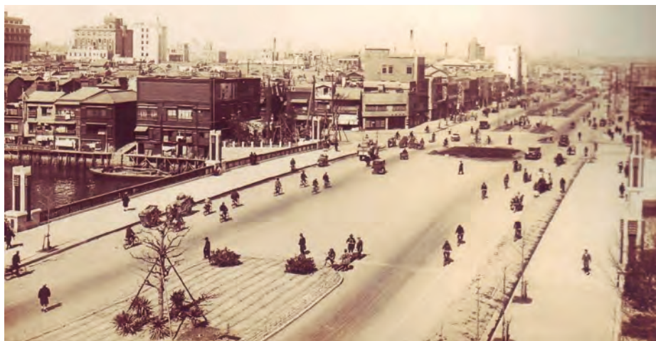
写真－1 震災復興で整備された昭和通り
