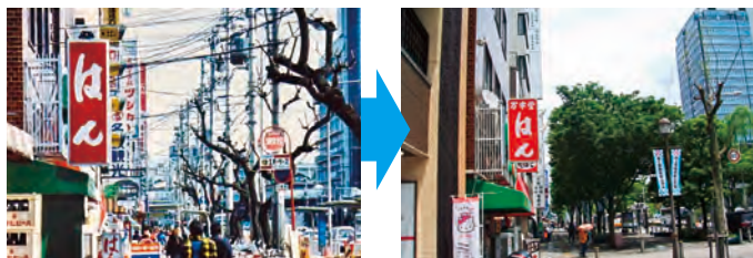
写真-2 電線類の地中化
