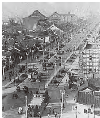
写真-1 建設当時の御堂筋
