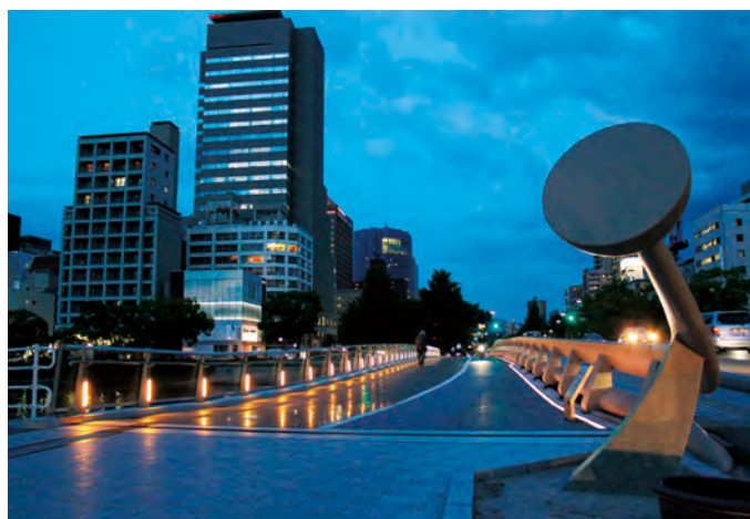
写真－5 平和大橋歩道橋
