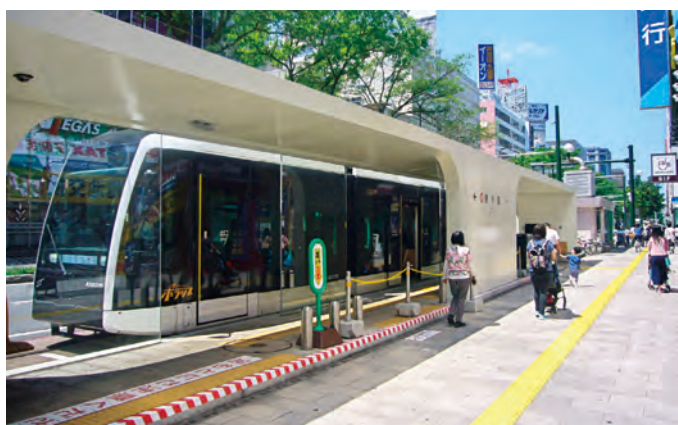
写真－4 狸小路停留場外観（サイドリザベーション）
