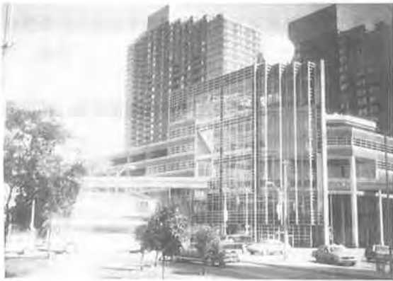
建物と一体となったミレンダ駅
