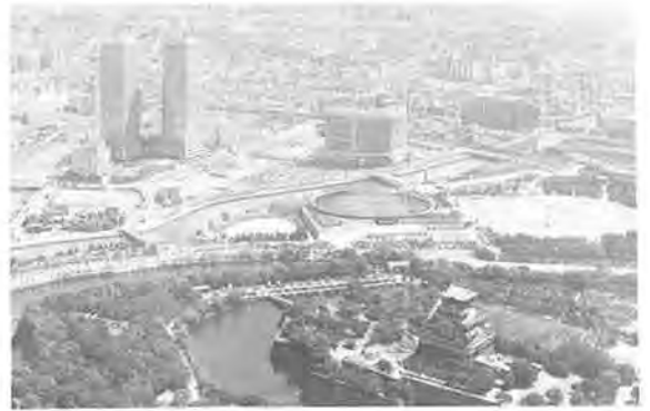
写真-3 建設が進むO.B.P地区
