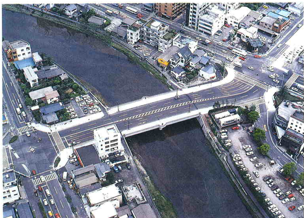
鹿児島県鹿児島市 平田橋
