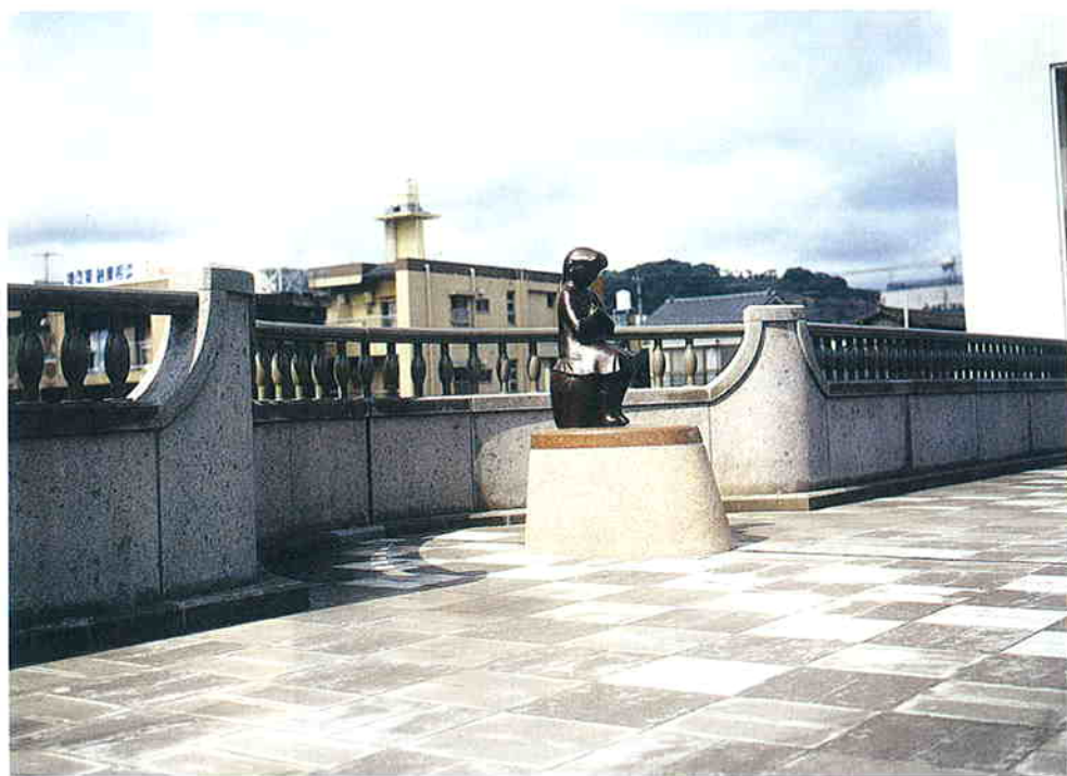
鹿児島県鹿児島市 平田橋
