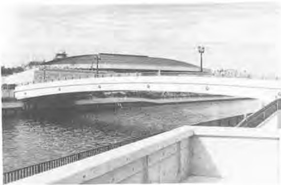
写真-2 大阪城新橋
